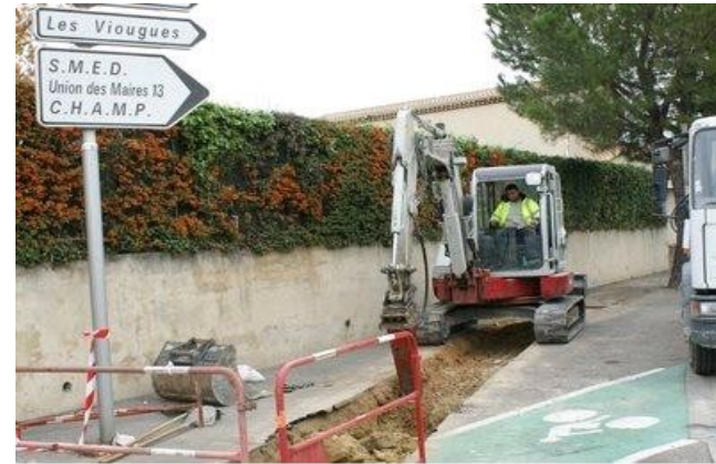
Réseaux enterrés, 30/11/11 - Salon de Provence (13)
