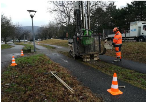
Atelier de forage
